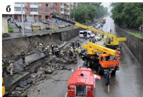
«Разрушение подпорной стены на проспекте Свободный» рисунок 2
